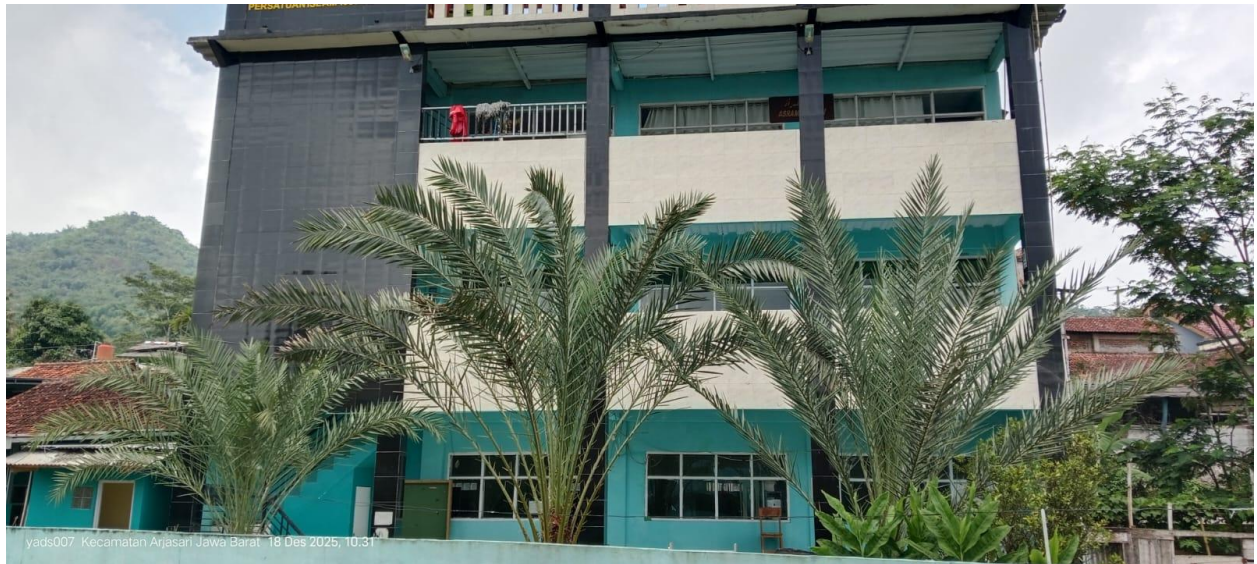
Pelataran atau Teras kelas ada tembok Penghalang yang cukup tinggi
